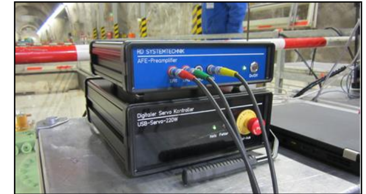
Mobiler Einsatz, Prüfung Generatorwelle und Kugelschieber
